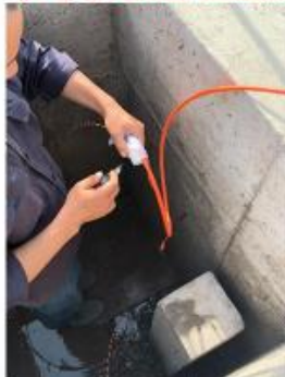
A 电缆接头绑上胶带防止损伤
