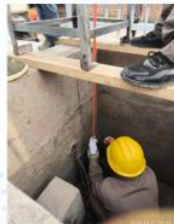
D 钢丝绳和电缆扎上绑带固定
