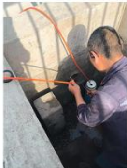
B 电缆线和穿线绳连接穿过走线管
